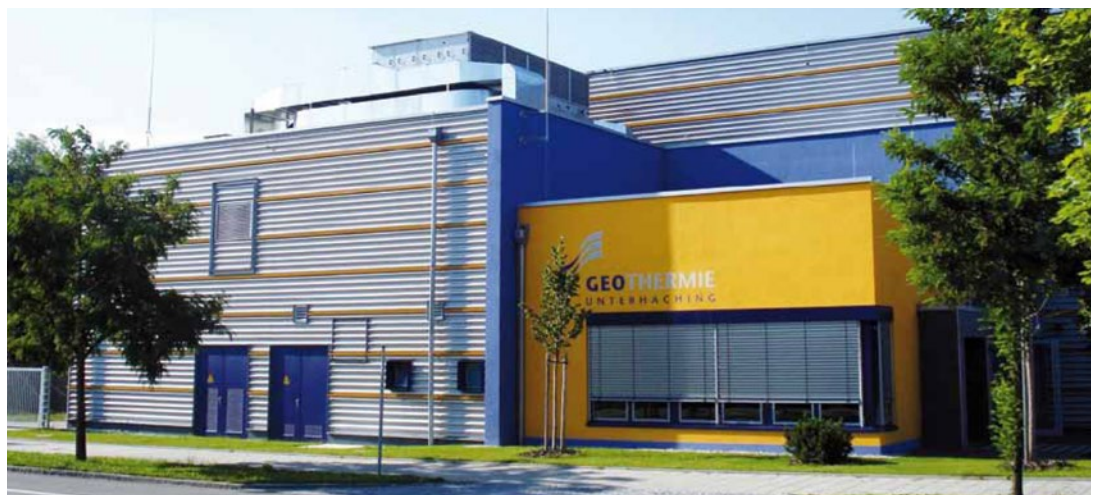
© Geothermie Unterhaching GmbH & Co KG
